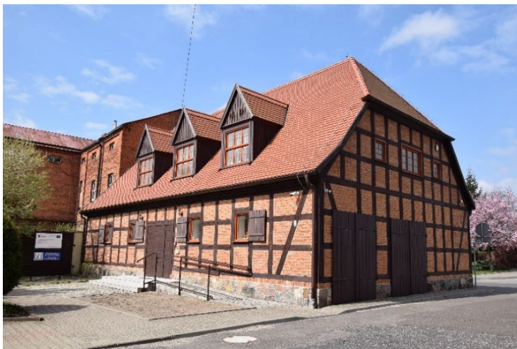
Budynek zabytkowego Magazynu Solnego w Drawsku. Fot. E. Hołubczat
