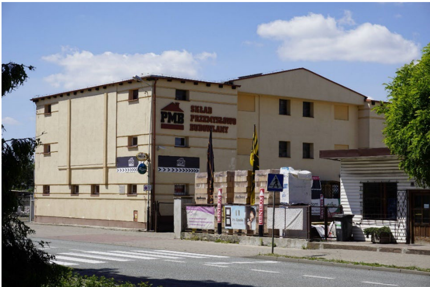
Spichlerz w Mirosławcu zaprojektowany przez Waltera Gropiusa. Stan z 2023 r.
